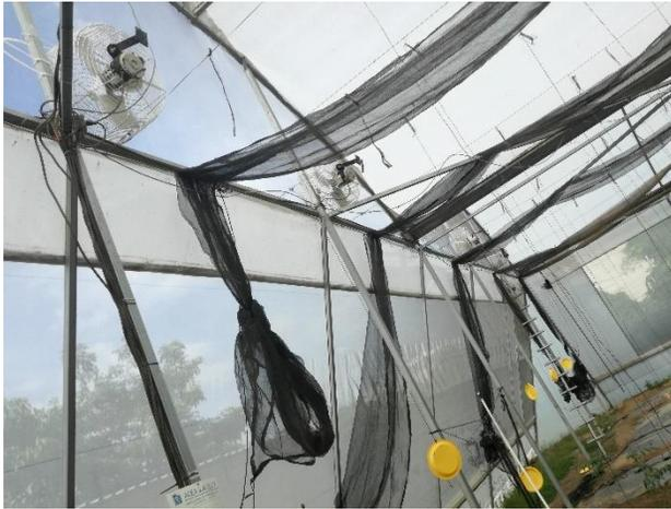
**Figura 9** Ventiladores montados como inyector-extractor
