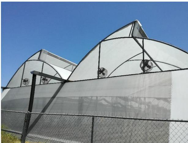
**Figura 8** Ventiladores como inyectores
